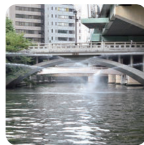
東横堀川水門
