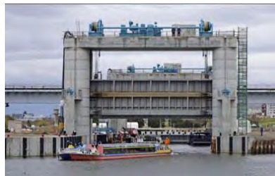
淀川大堰閘門 淀川ゲートウェイ
