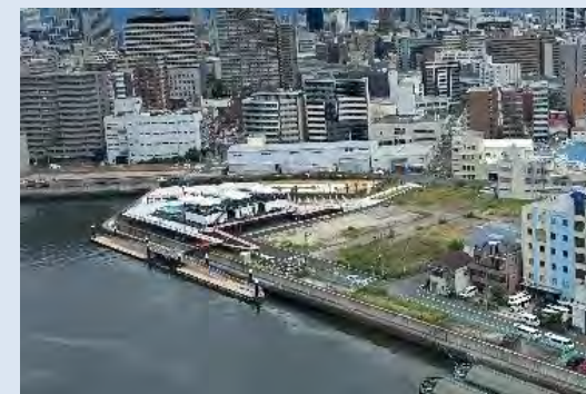
【中之島GATEサウスピア】
